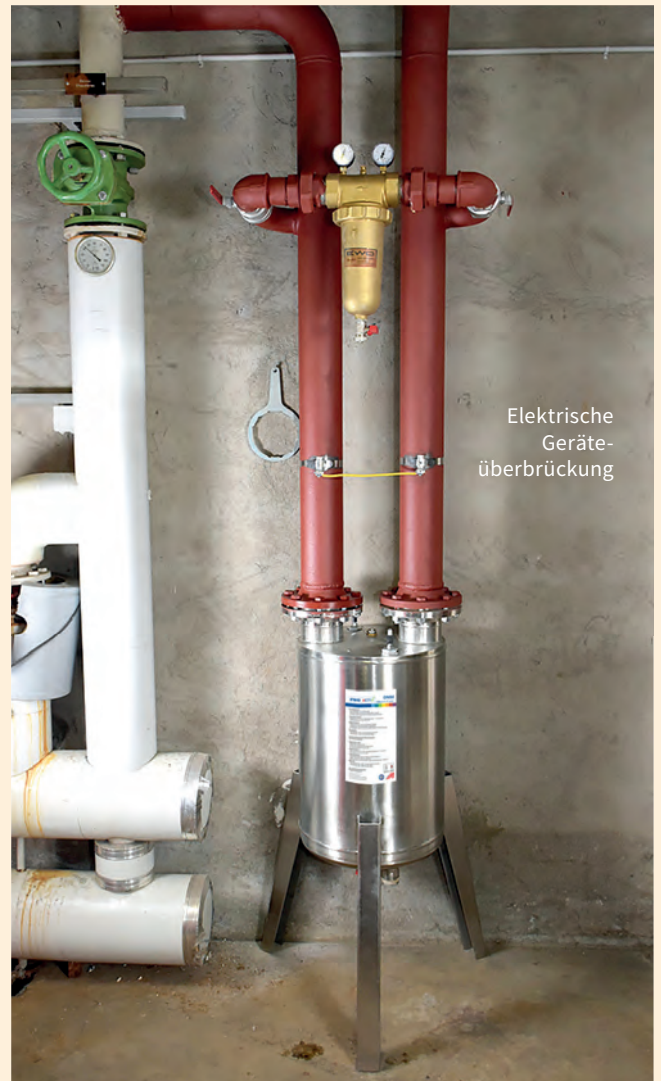
Heizungsschutzfilter im Teilstrom z.B. für Bestands- und Sanierungsanlagen
